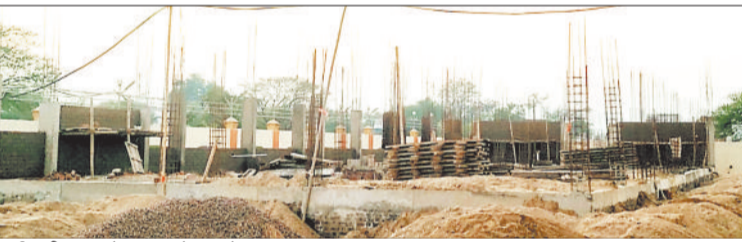
निर्माणाधीन अग्रसेन भवन के कमरे।
